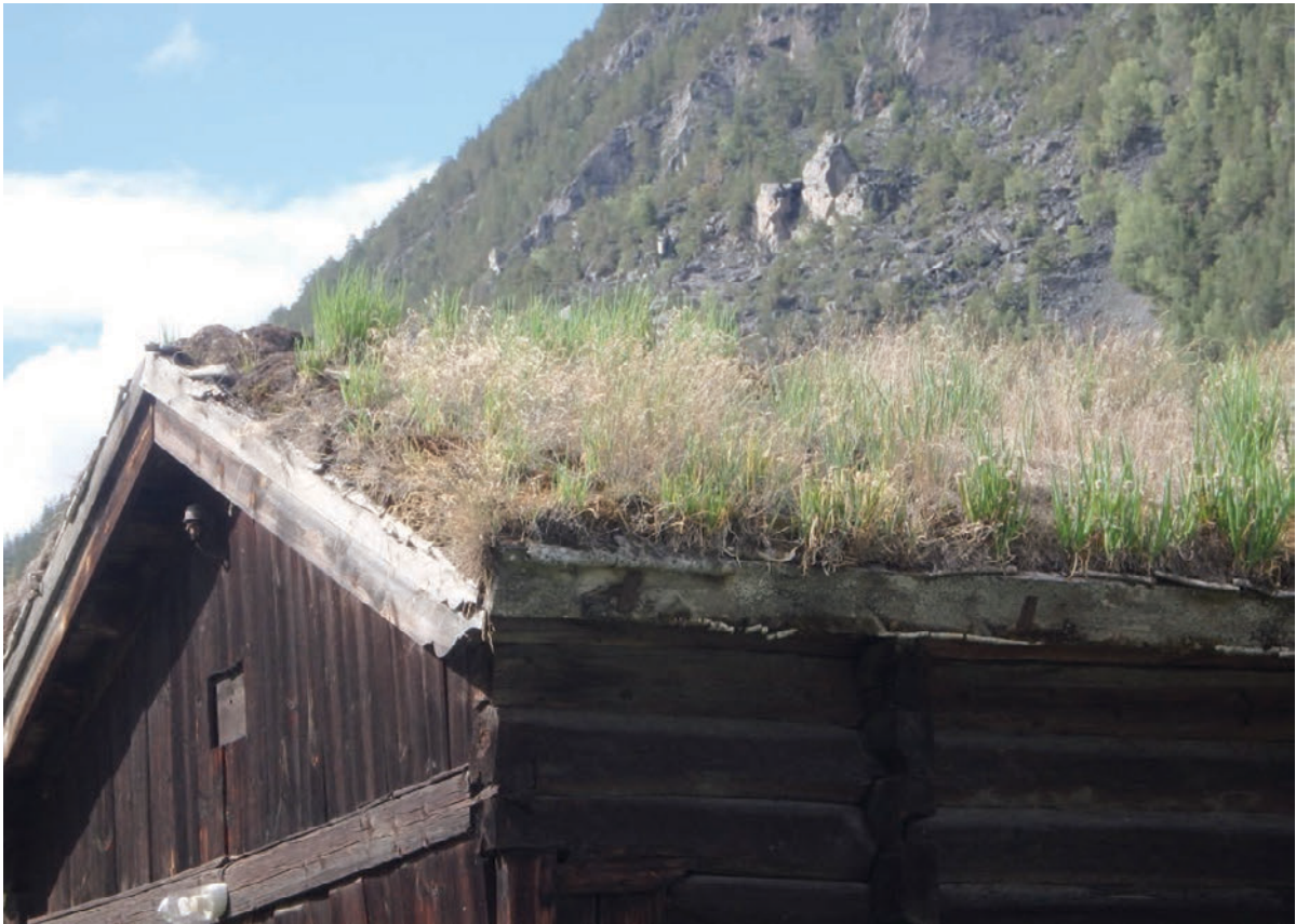
Figur 53. Tett bestand av pipeløk på stabburstaket mot sør. Foto: Bjørn Harald Larsen.
