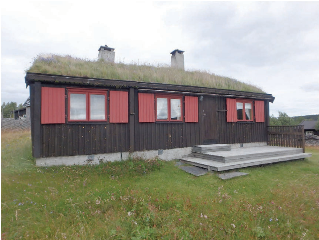
Figur 12. Hytte på Rudilandet på Valsætrin hvor pipeløk vokser på det sørvendte torvtaket. Foto: Bjørn Harald Larsen, 3.8.2016.
