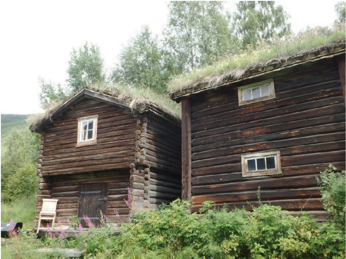
Figur 39. På sørsida av stabburet var det tett bestand av pipeløk, mens det kun ble funnet ett individ på løetaket som står tett inntil stabburet mot sør. Foto: Bjørn Harald Larsen.
