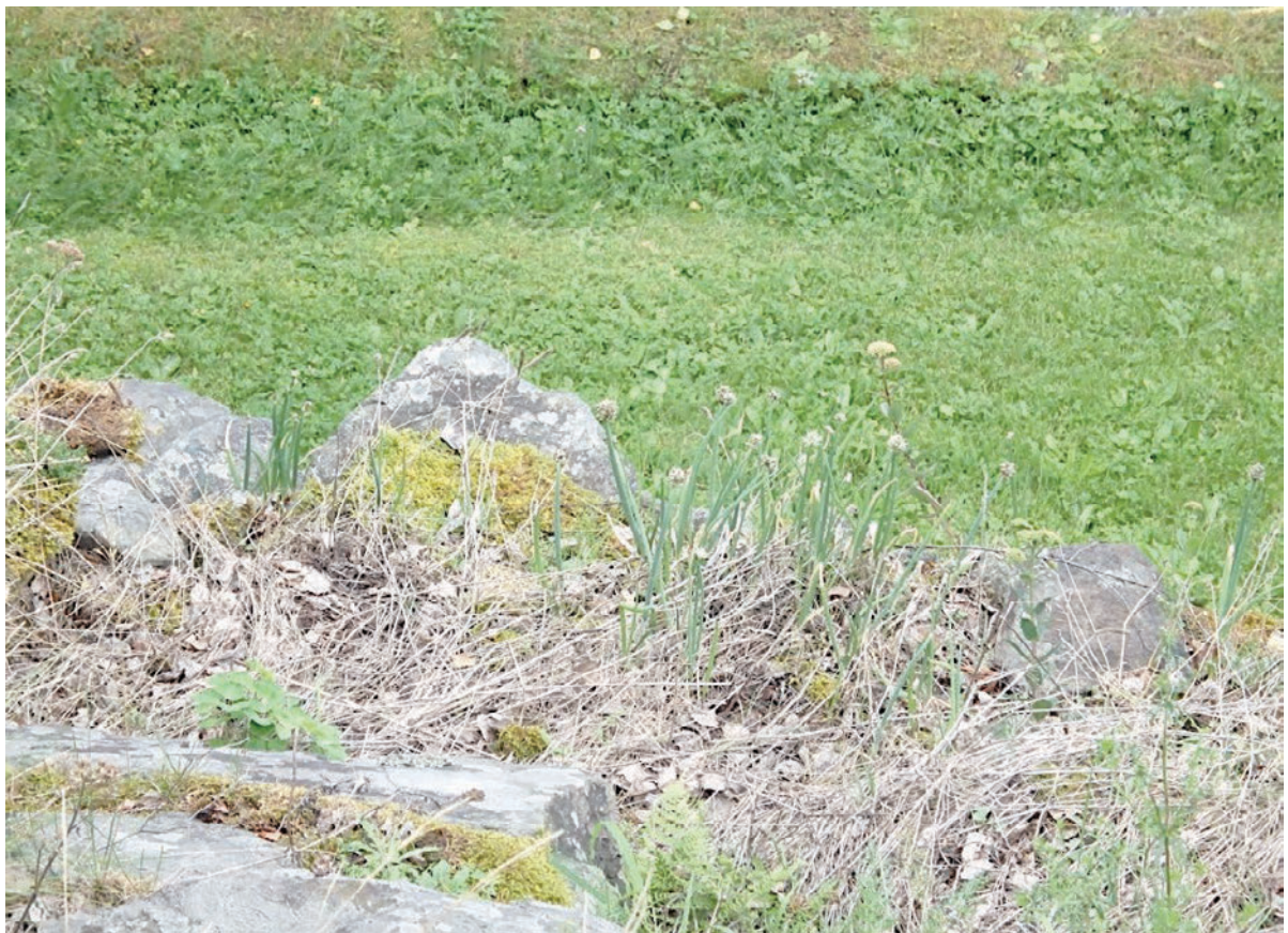
Figur 30. Pipeløken vokste på tørrbakke i overkant av en mur mellom Kongsvegen 16 og 18. Foto: Bjørn Harald Larsen.
